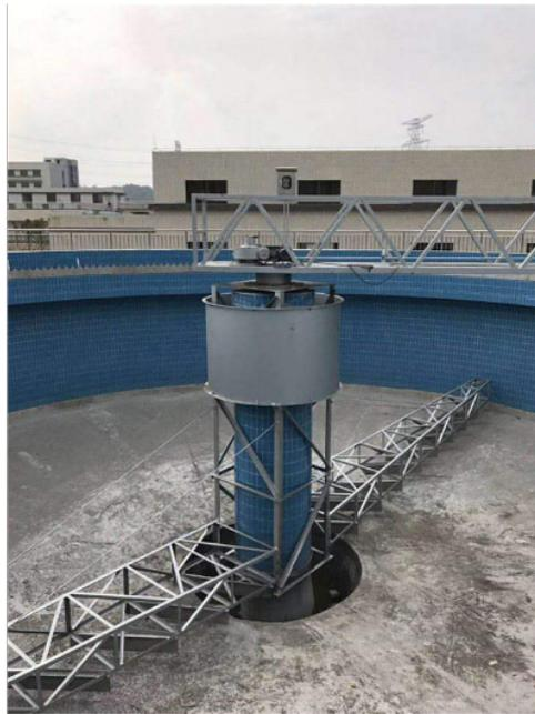
中心传动刮泥机采用中心传动、悬挂式，污水从工作桥下进水管流入导流筒扩散后，均匀的向周边呈辐射状流出，呈悬浮状的污泥经沉淀后沉积于池底，驱动装置带动中心立轴旋转，并带动刮臂及刮泥板转动，将污泥从池周刮向中心集泥槽后，靠池内静水压由排泥管排出池外，水面上的浮渣通过旋转撇渣装置撇向池边，再由刮渣耙刮进排渣斗内排出池外；而上清液则通过三角形出水堰板溢入出水槽内排出。中心传动刮泥机的主要特点：1、驱动装置采用三级摆线针轮减速机传动，传动稳定，结构紧凑，机械效率高；2、刮泥机立轴下端设有水下支承，避免立轴转动时的偏摆；3、设置机械和电子双重过载保护，运转安全可靠；4、设备操作简便，可直接就地/远程控制设备的运行。苏州刮泥机选型哪家强刮泥机具有重量轻、刚性好的特点。
